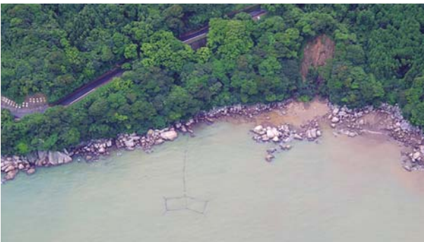
海岸部で発生した土砂崩れ
