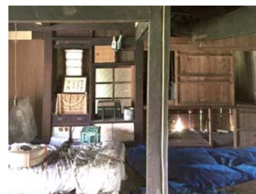
改修中の古民家
