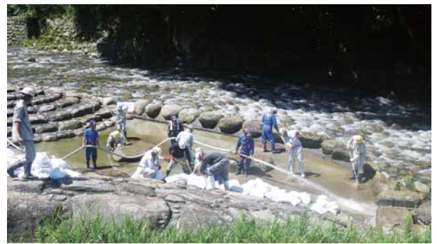
轟の滝周辺での作業
