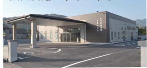
天山会館 うちのうら
