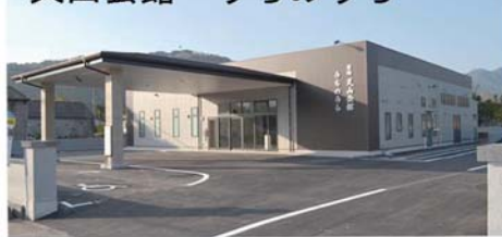
天山会館 うちのうら
