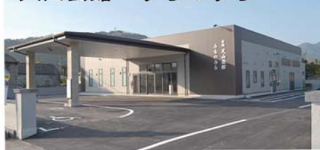
天山会館 うちのうら
