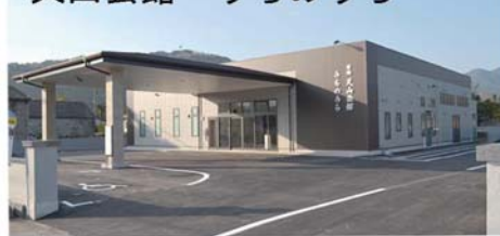
天山会館 うちのうら
