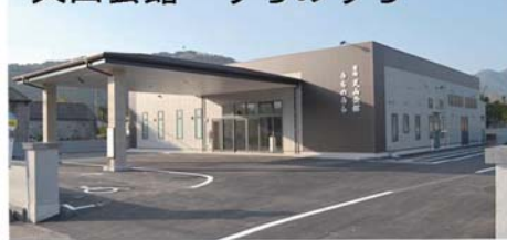
天山会館 うちのうら
