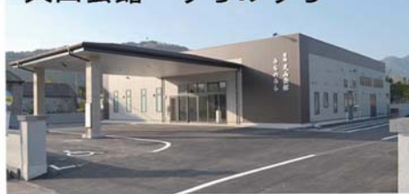
天山会館 うちのうら
