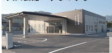
天山会館 うちのうら
