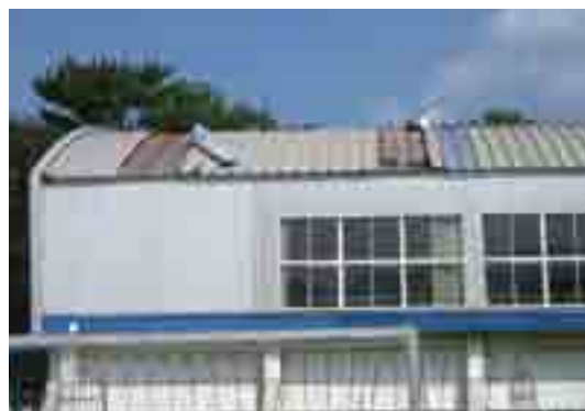
内之浦小学校体育館
