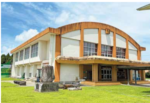
災害時避難所に指定されている 国見中体育館
