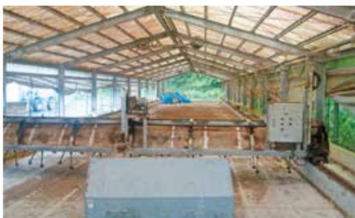
天日乾燥施設 (レール変形により使用されていない)
