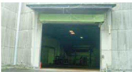
害虫などの侵入防止のシャッター (故障のため数年前から稼働していない)
