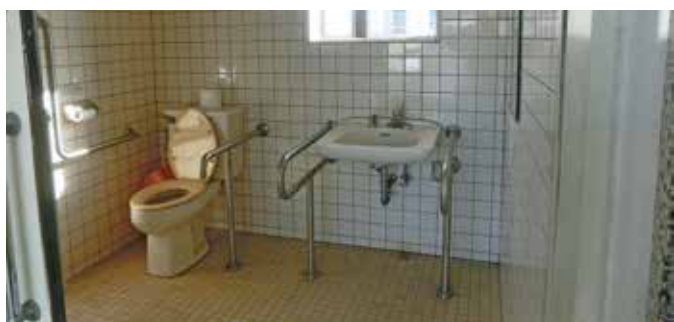
町体育館前の公共トイレ（多目的トイレ）
