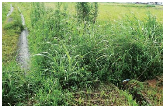
▲ 水路に繁茂した畦畔の雑草
