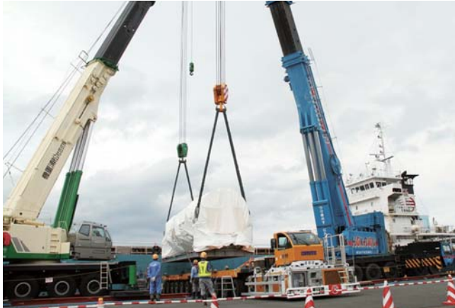
▲ 2台のクレーンによる水切り（陸揚げ）
