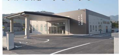
天山会館 うちのうら
