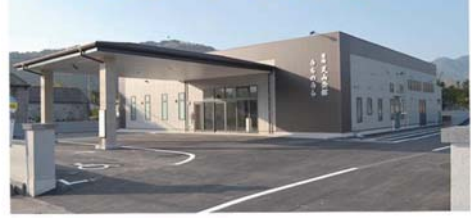
天山会館 うちのうら
