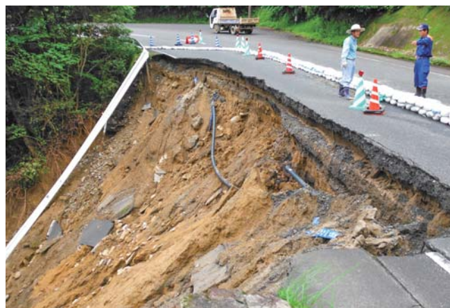
▲内之浦 宮原付近 (2012.6.30)
