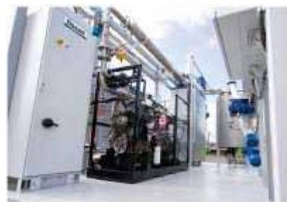
発電出力 40kW, 热出力 100kW, 原料投入量(チップ)300t/年
