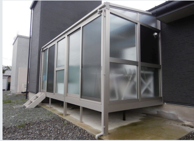
基礎工事が施され、屋根、壁があるサンルーム
