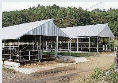
壁がなく、外気分断性を欠く建物
