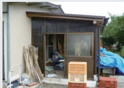
既存家屋の外壁を利用して増築したブロック基礎の物置
