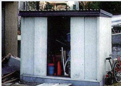
基礎工事が施されている物置
