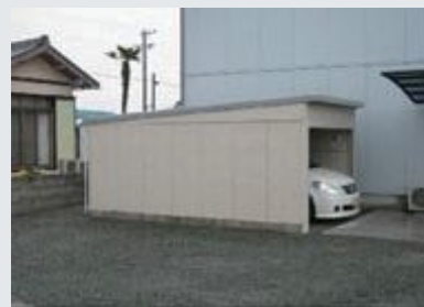
壁（三方向）があるブロック基礎の車庫
