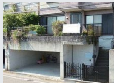
居宅と構造を別にする地下車庫（カルバード車庫）
