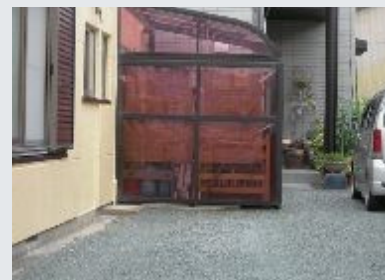
壁（三方向）があるが、簡易なもので基礎が施されていない物置
