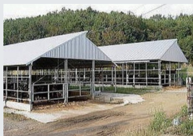
壁がなく、外気分断性を欠く建物
