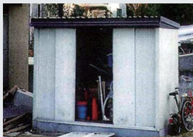
基礎工事が施されている物置
