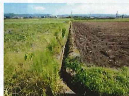
図10 管理不十分で埋没した排水路(左)と管理の行き届いた排水路(右)
