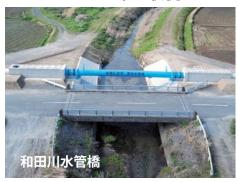
荒瀬ダムに貯まった水は道路等に埋設された直径約 1mのパイプライン(幹線水路)を通って一時的に水を貯留する施設であるファームポンドへ送られます。本町に関連する工事としては野崎の和田川の水管橋や下永山に建設予定である肝付ファームポンドにつなぐパイプラインが施工されました。
