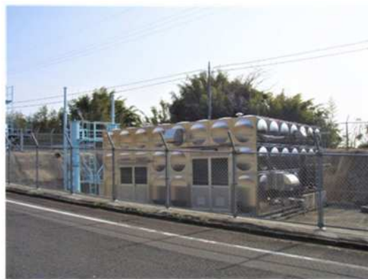
船間浄水場・配水池
