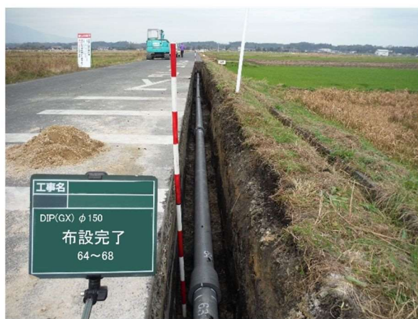
耐震管の布設状況
