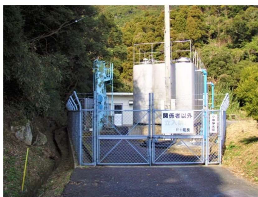
小串浄水場・配水池
