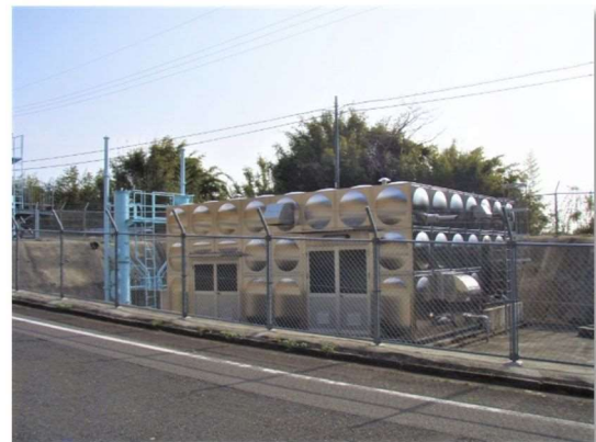
船間浄水場・配水池
