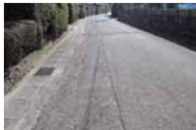
コンクリート舗装
