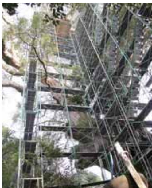
写真3：樹勢回復工事中のクス
