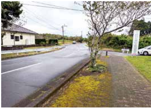
注意喚起が必要な危険箇所
