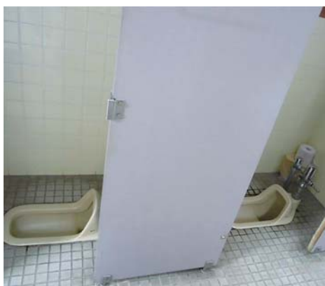
庁舎内のトイレ
