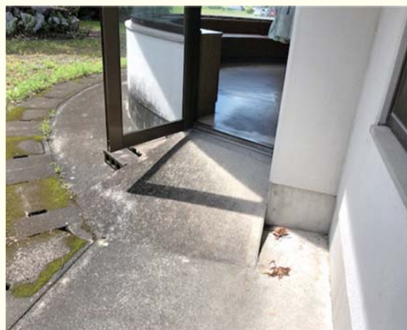
避難場所からの出口。傾斜が急である
