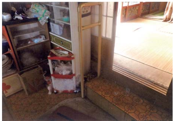
介護住宅改修後
