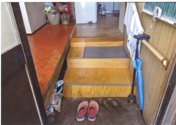
介護住宅改修後
