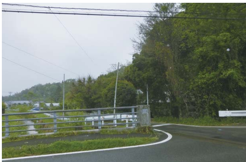
後田研修センター出入口付近
