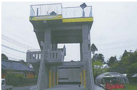
下伊倉地区津波避難タワー
