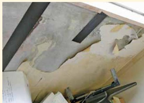
カルテ保管庫窓側（雨漏れによる腐蝕）
