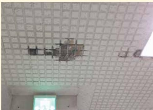
天井（雨漏れによる腐蝕）
