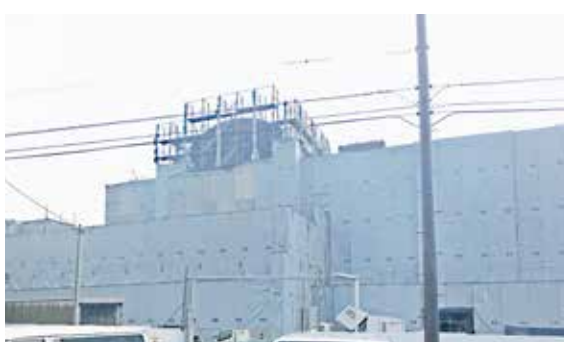
解体中のコスモピア内之浦
