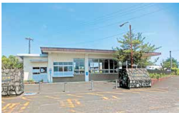
現在の高山駅舎跡
