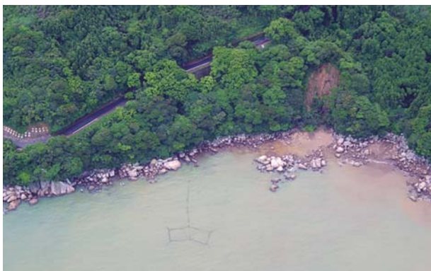
海岸部で発生した土砂崩れ
