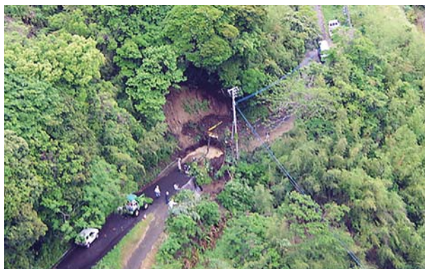
道路脇の土砂崩れ
