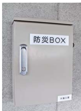
震度5以上を感知すると自動で開く仕組みです
