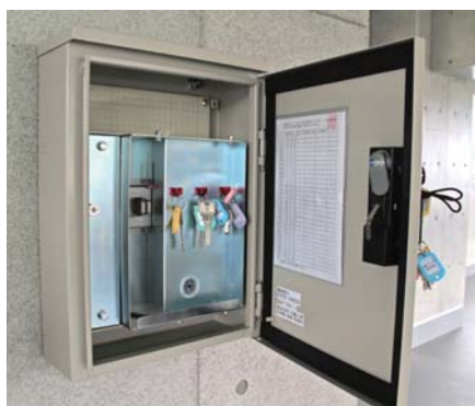
震度5以上を感知すると自動で開く仕組みです
