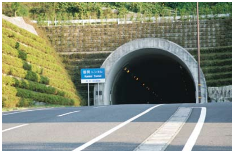
国見トンネル
